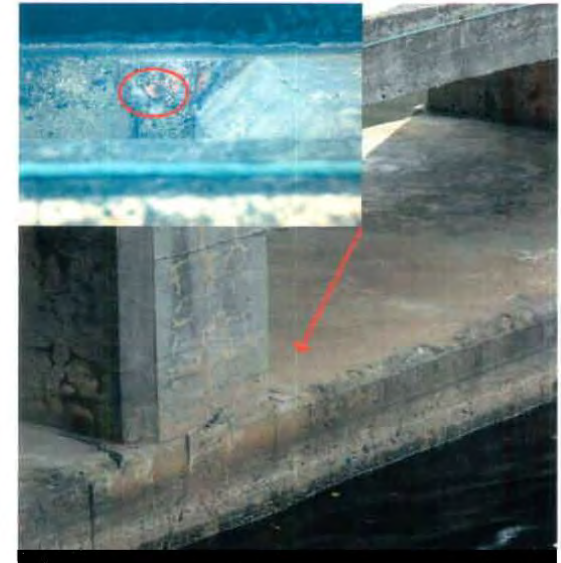
Bilde 7. Detale fra overløpet med fastmerke punkt på overløpet.
