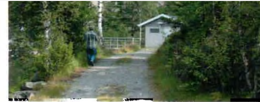
Bilde 2. veien inn til dammen. Opplysningskilt kan plasseres på bygningen rett fram i bildet.
