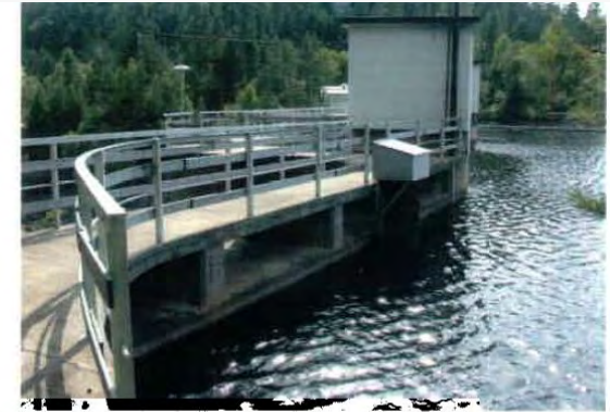
Bilde 6. Overløpet sett fra innersida av dammen.
